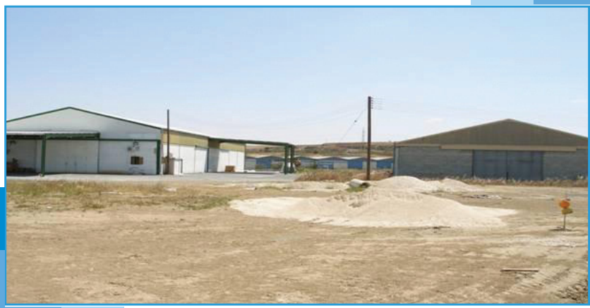
Παρατηρούνται ελλείψεις σε έργα υποδομής στις βιομηχανικές ζώνες/ περιοχές
