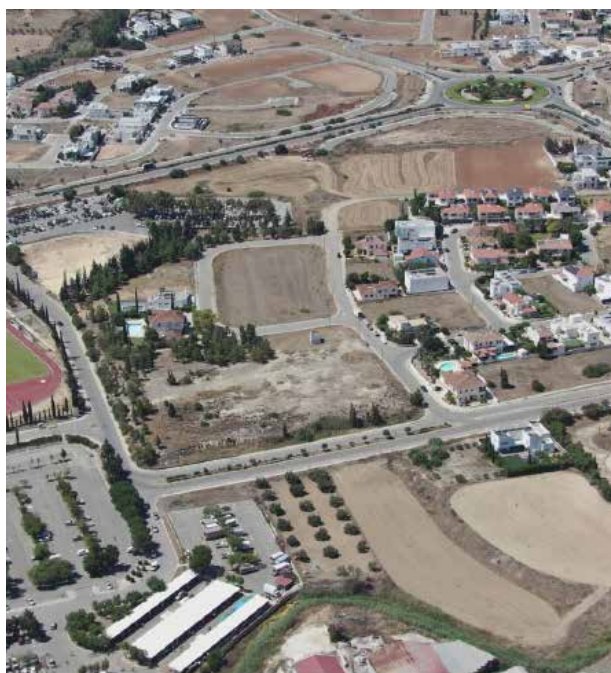
Εκκρεμεί η επέκταση της Λεωφόρου Αργυρουπόλεως με κατεύθυνση την Λεωφόρο Τσαρίου
